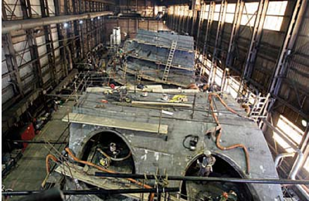
La méthode japonaise : les feuilles d'acier forment des modules qui sont assemblés à l'envers pour faciliter le travail. Tels des blocs Lego, ils sont ensuite imbriqués les uns dans les autres.
